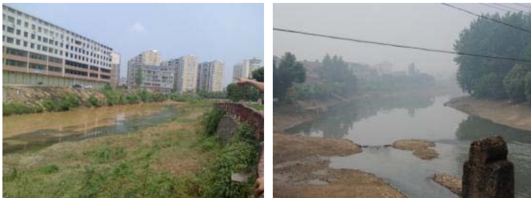
图 1-12 通山河新城段河道淤积、淦河大畈陈闸发电站上游河道淤积
