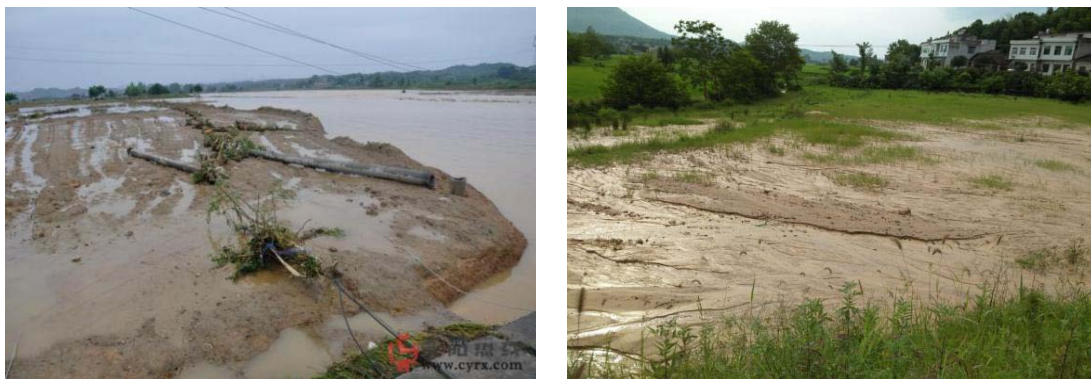
图 1-10 水毁农田，水毁河堤、公路、电力设施
