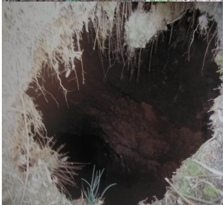
崇阳路口镇沙坪岩溶地面塌陷
