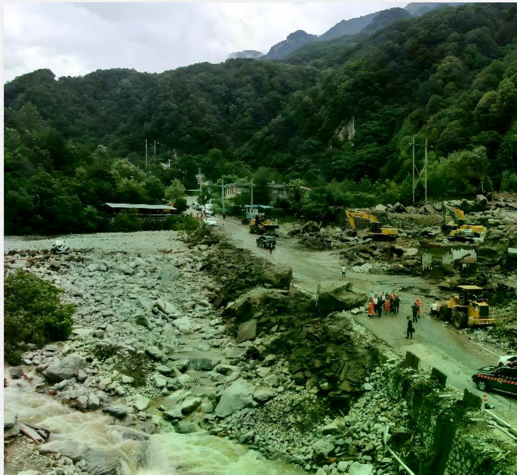
泥石流灾害现场实景
