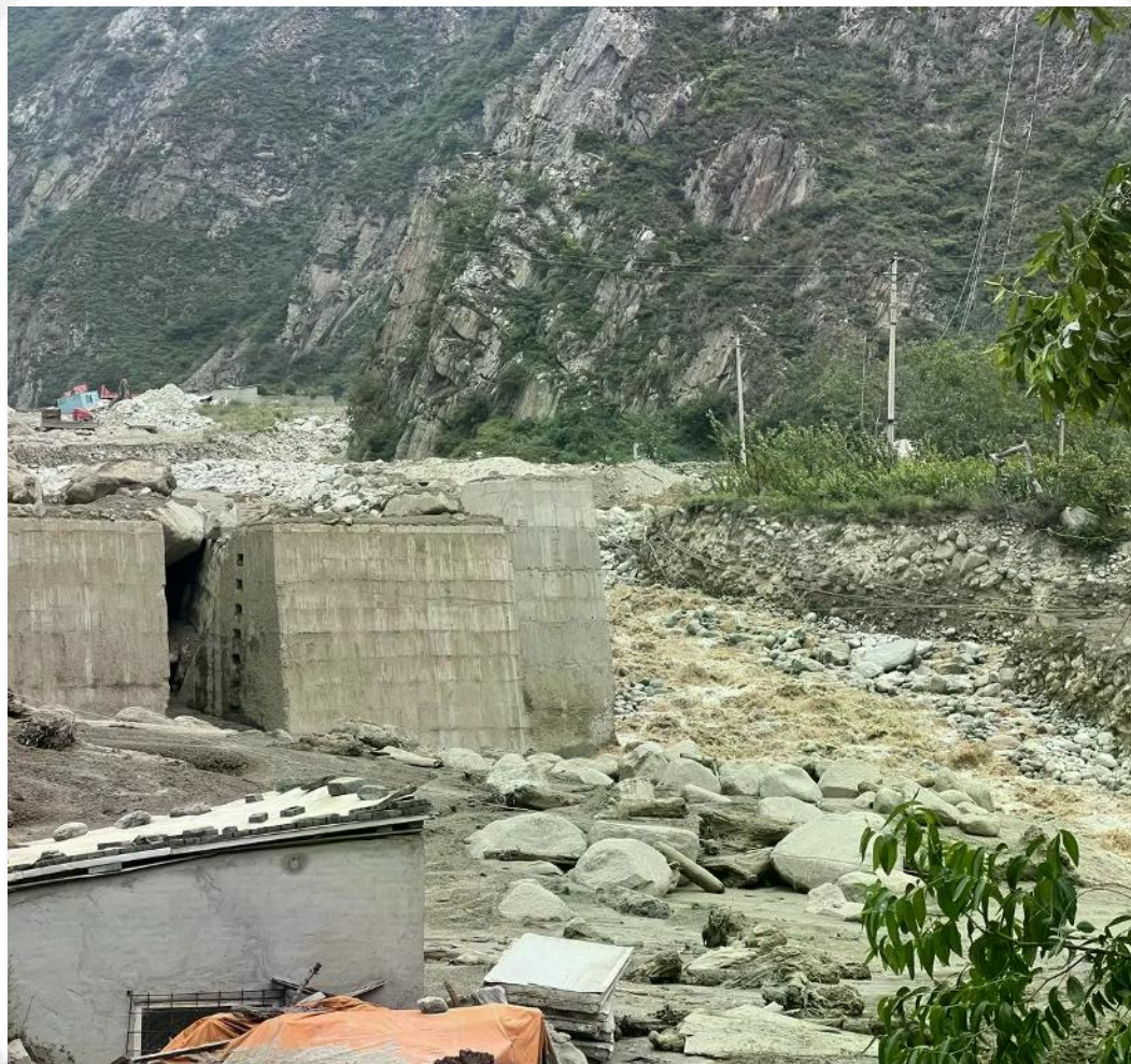
📷 泥石流拦沙坝工程实景
