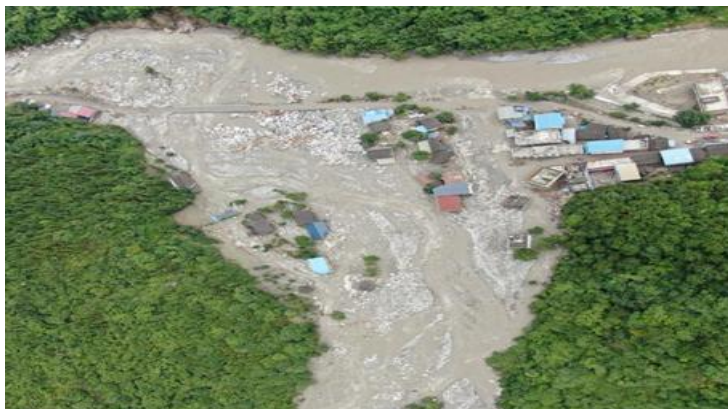
2022年平武县7.12山洪泥石流
